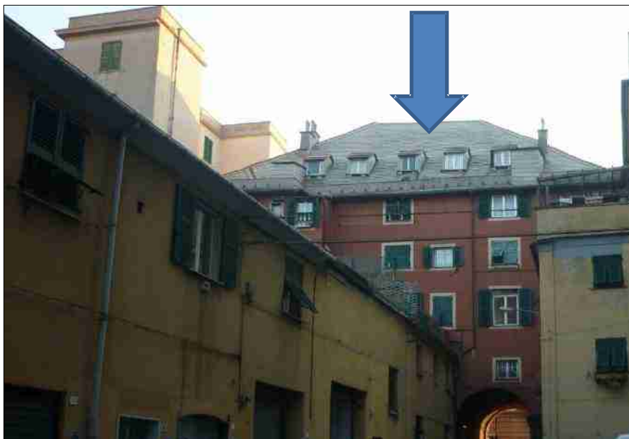
Foto n°1 – Vista da Nord
