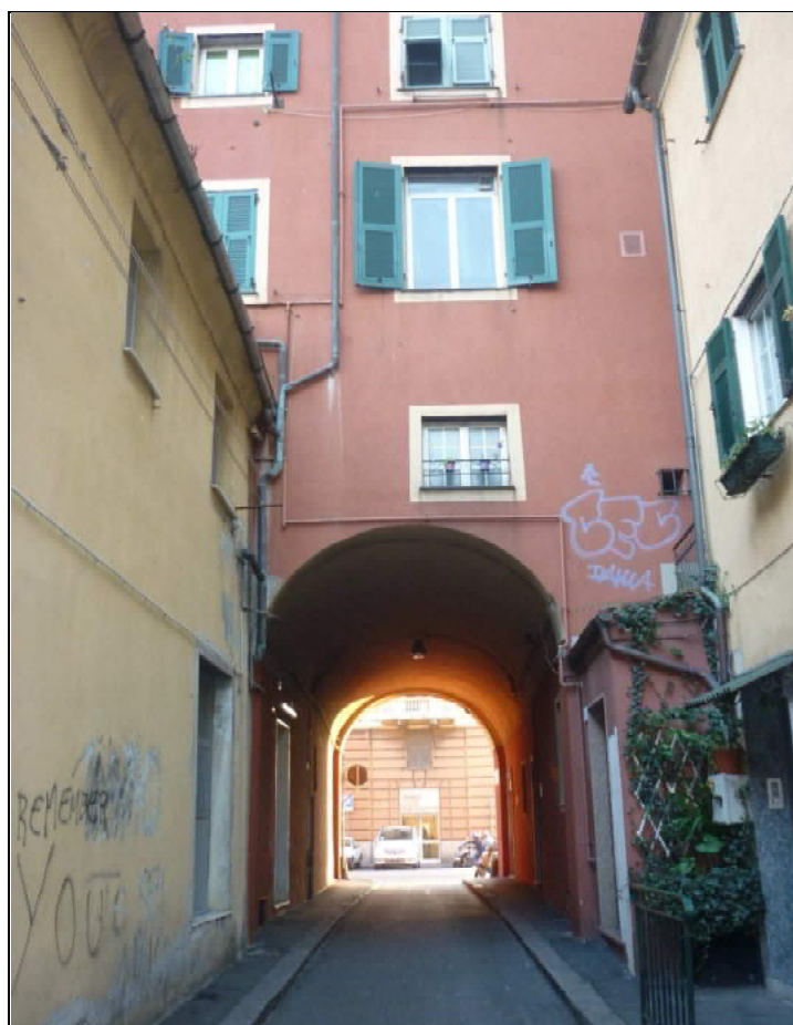
Foto n°2 – Vista da Nord
