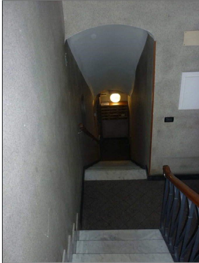
Foto n° 5 – Prima rampa di scale
