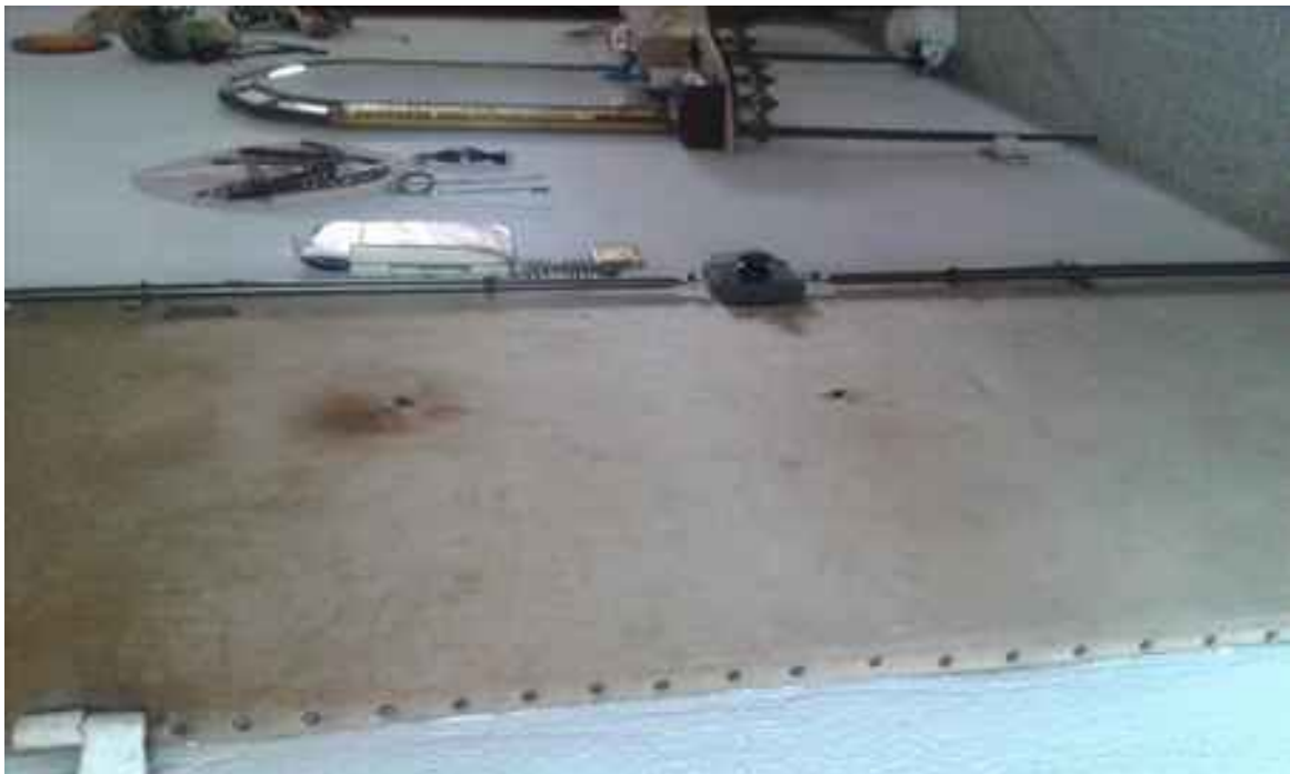
PORTA D'INGRESSO INTERNO 8
