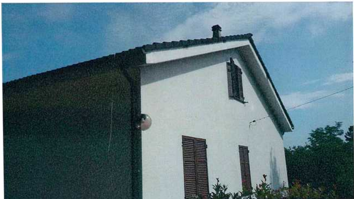
FOTO n.° 4: prospetto sud della casa
