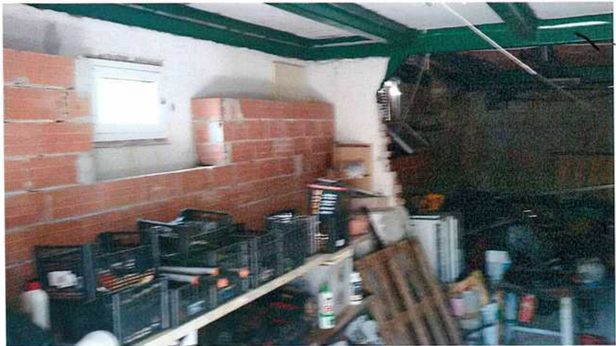
FOTO n.° 8: piano seminterrato
