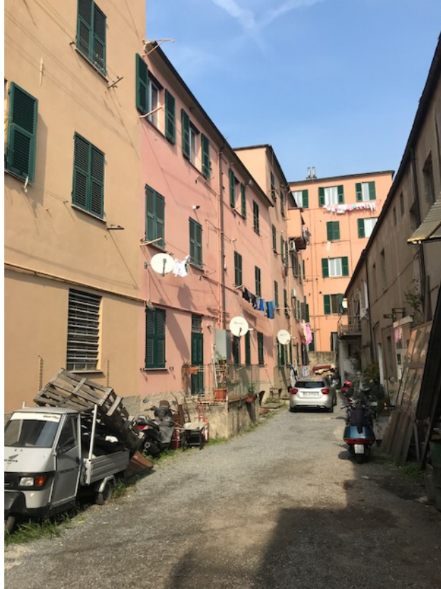
Foto 03 – Facciata sud/est (lato ferrovia)
