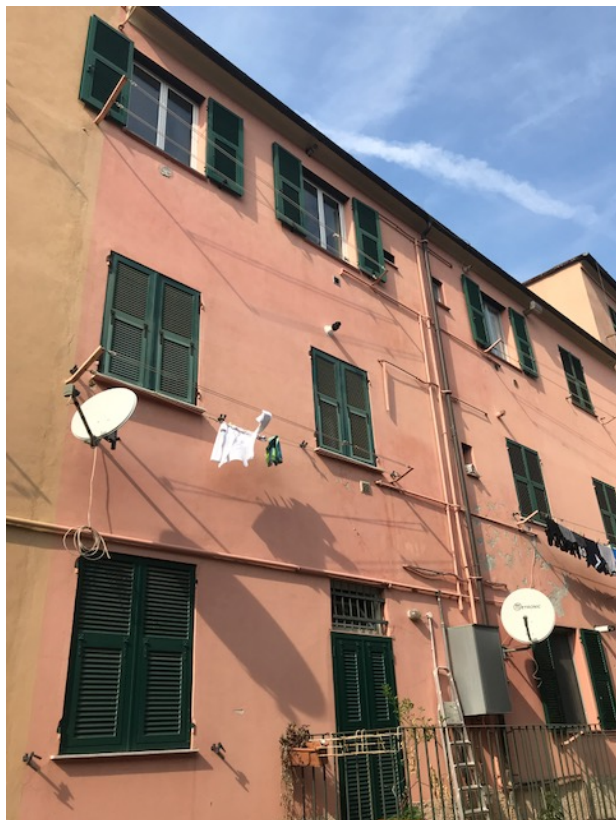
Foto 04 – Facciata sud/est (lato ferrovia)
