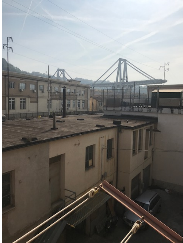
Foto 07 – Vista lato ferrovia verso Ponte Morandi
