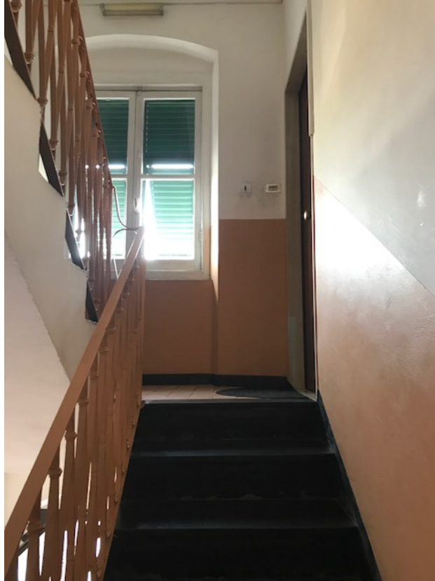
Foto 09 – Vano scala condominiale
