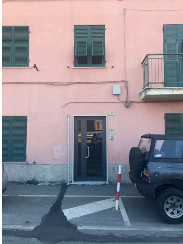
Foto 01 – Portone di accesso da Via Argine Polcevera 11
