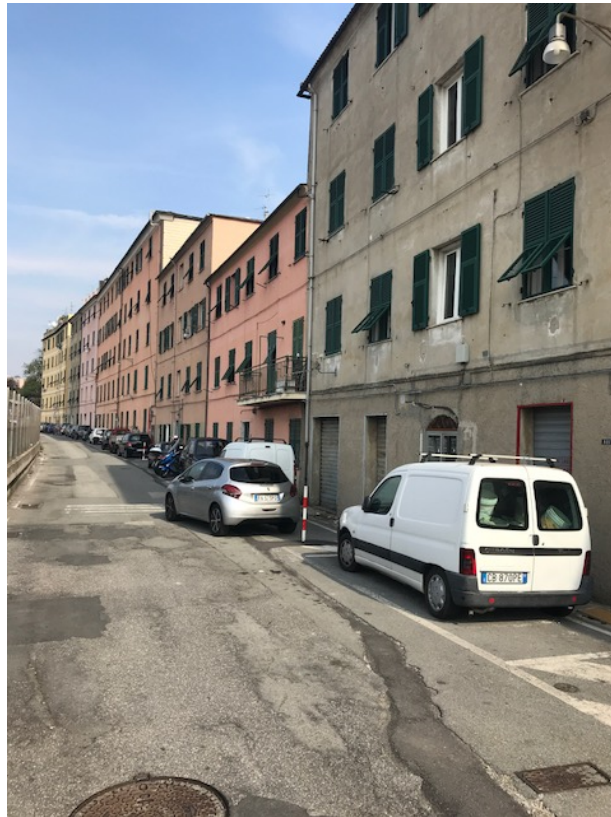
Foto 05 – Facciata nord/ovest (via Argine Polcevera)
