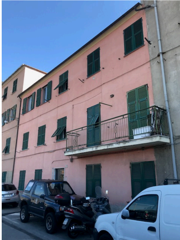
Foto 02 – Facciata nord/ovest (via Argine Polcevera)
