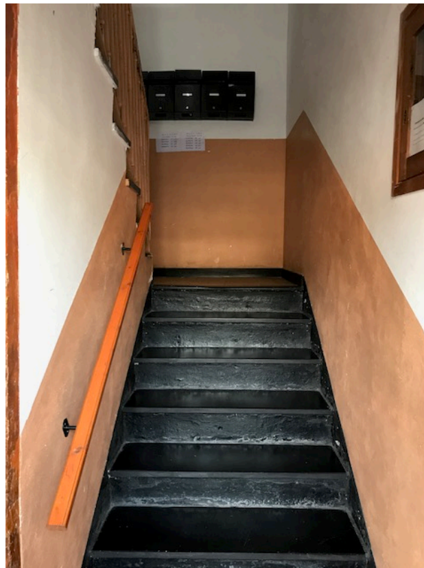
Foto 08 - Vano scala condominiale
