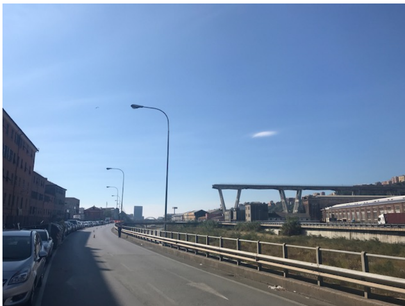
Foto 06 – Vista da via Argine Polcevera verso Ponte Morandi
