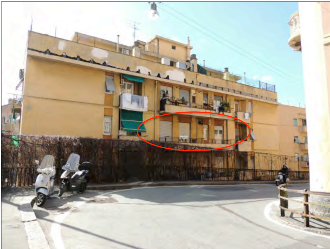
Foto 11 – il fabbricato da via Balbi Piovera, le quattro finestre centrali al penultimo piano appartengono all'immobile oggetto di perizia
