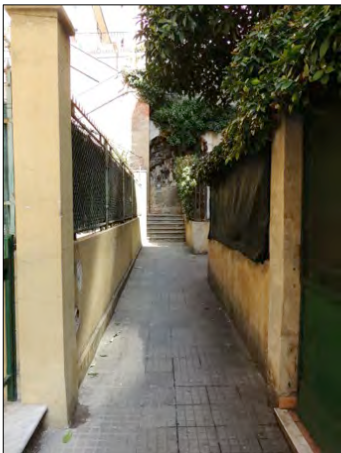
Foto 5 – il percorso pedonale di accesso al portone del civ.1 sulla destra al centro della fotografia.
