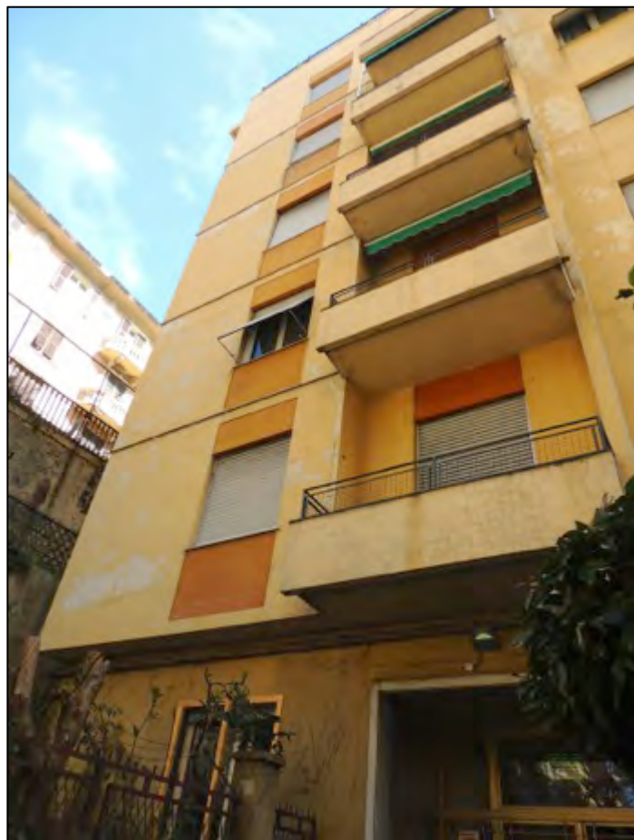
Foto 7 – il fabbricato visto dalle adiacenze del portone
