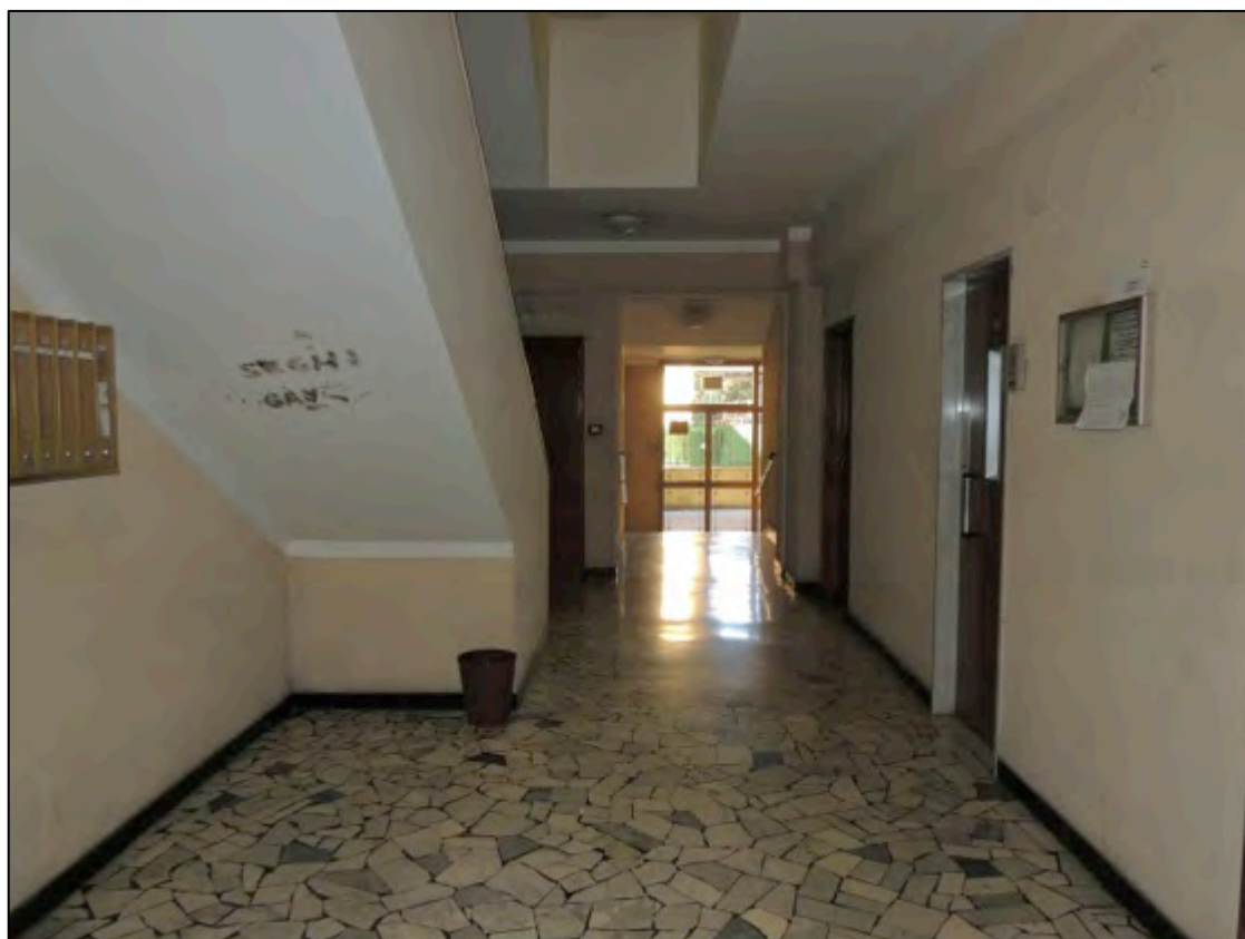
Foto 7 – il vano scala
