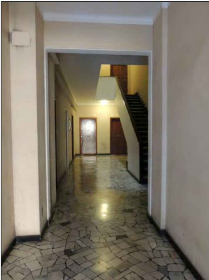
Foto 5 – il vano scale al piano terreno
