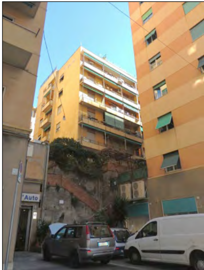
Foto 1 - La scalinata che sale da via Pittaluga verso l'accesso al fabbricato civico 1 al centro della fotografia,
