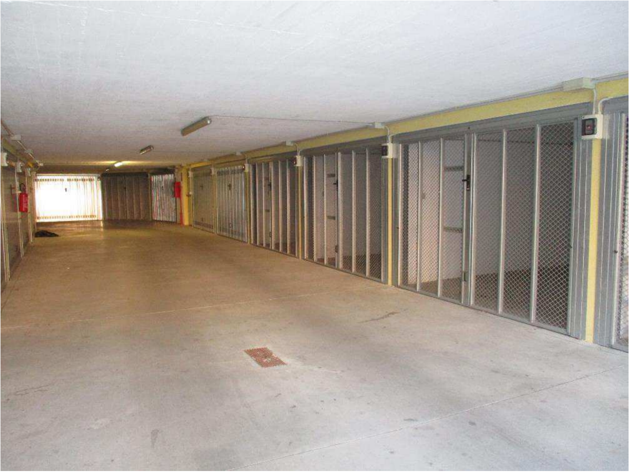
VISTA AREA DI MANOVRA
