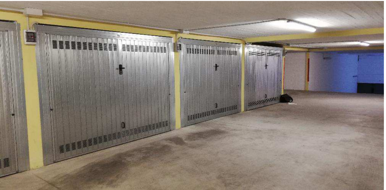
VISTA AREA DI MANOVRA
